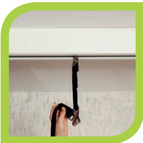
Der Distanzgurt wird auf die Höhe des jeweiligen Raumes eingestellt. Das Aushaken des Tragegurtes erfolgt bei abgelassener Kassette von Hand oder mit einem Hilfswerkzeug.
